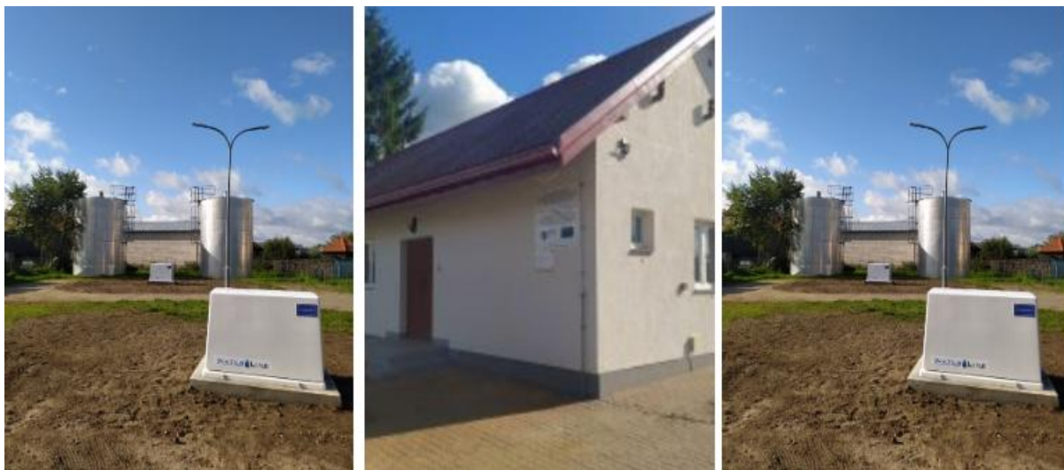
Stacja uzdatniania wody w Łojach - Awissa
