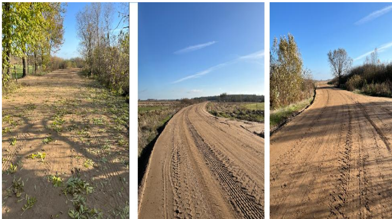
Drogi gminne nr 162737B i 162591B w obrębie gruntów msc. Mścichy
