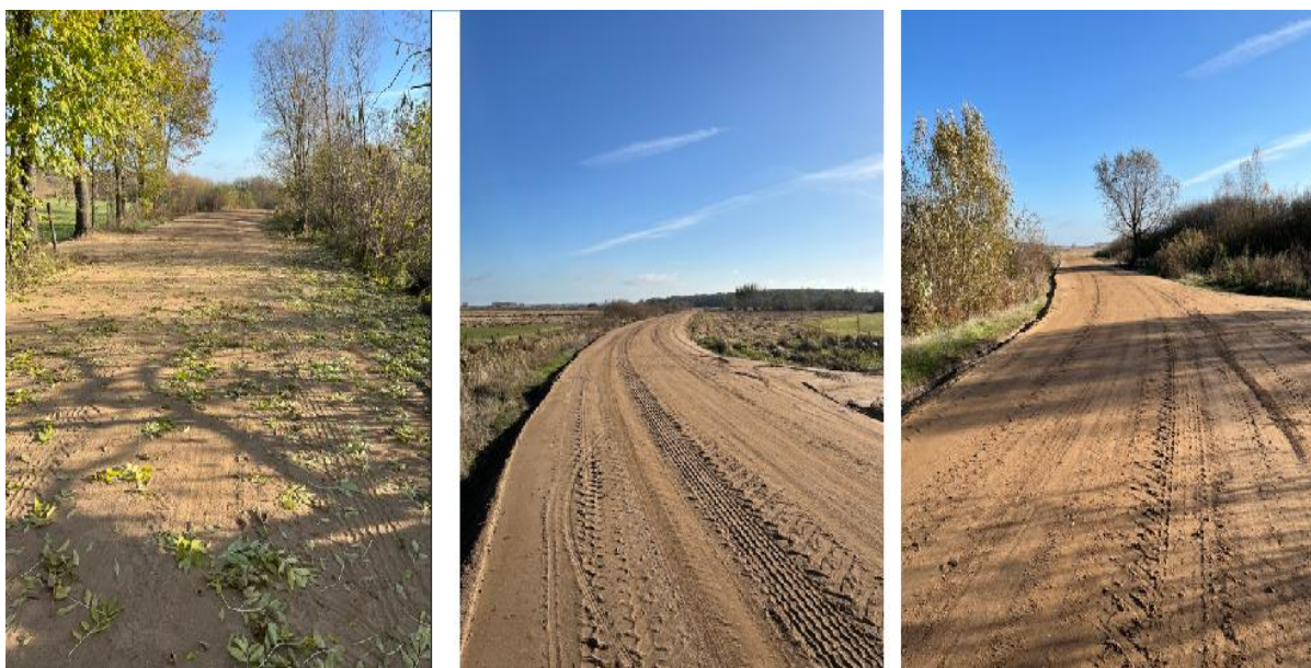
Przebudowa drogi gminnej 162737B w obrębie msc. Mścichy.
