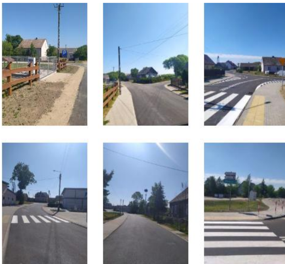
Przebudowa drogi gminnej 162737B w obrębie msc. Mścichy.
